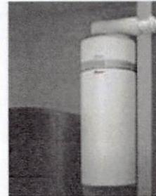
c. Solution 2 : Un seul percement (entrée et sorties d'air concentriques)
