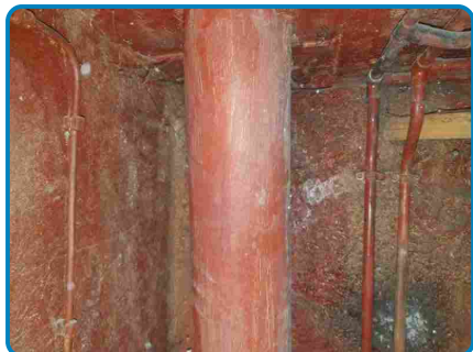
D.O. n° 1 sur Conduit(s) de fluide Fibres ciment
