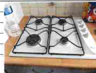
(1) **Non raccordé (Type A)** : Appareil qui n'est pas destiné à être raccordé à un conduit ou à un dispositif d'évacuation des produits de combustion vers l'extérieur du local dans lequel il est installé.
