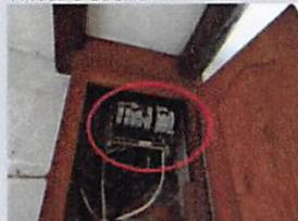
L'enveloppe du matériel est manquante ou détériorée. Les protections électriques doivent être entières et non dégradées pour que les occupants soient en sécurité à tout instant.
