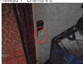
Au moins un socle de prise de courant ne possède pas un puit de 15 mm IC
