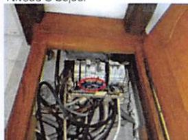
A l'intérieur du tableau, la section d'un(des) conducteur(s) alimentant les dispositifs de protection n'est pas adaptée au courant de réglage du disjoncteur de branchement. Il faut que la dimension des fils électriques soit en adéquation avec le disjoncteur de branchement.
